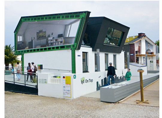
„Ontop“ überträgt das Thema Aufstockung auf ein typisches 50er-Jahrehaus und setzt auf Fertighausbauweise.
