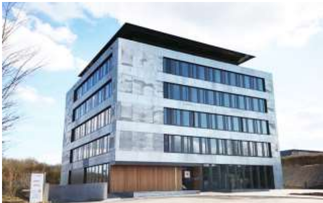
Abb. 60: Aufnahme des GoLav Firmensitzes in Niederanven (Luxemburg) (Quelle: Markus Lichtmeß, Goblet Lavandier & Associés Ingénieurs-Conseils).
