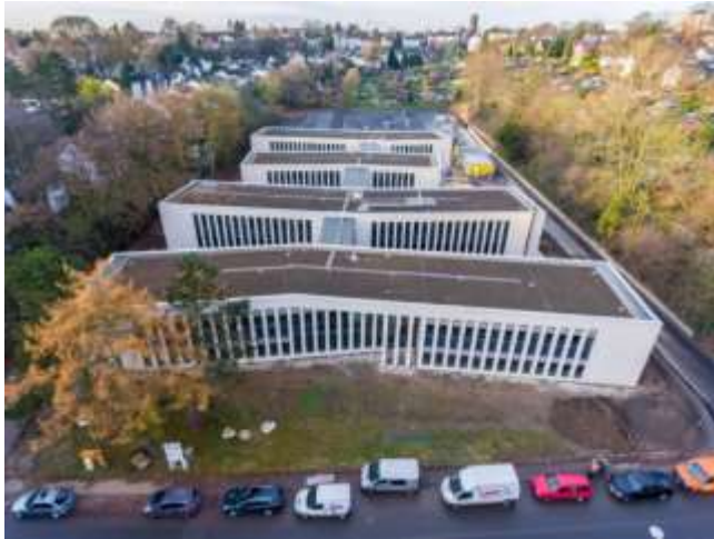
Abb. 37 Luftaufnahme des VG2 in Mettmann. (Quelle: Kreisverwaltung Mettmann)
