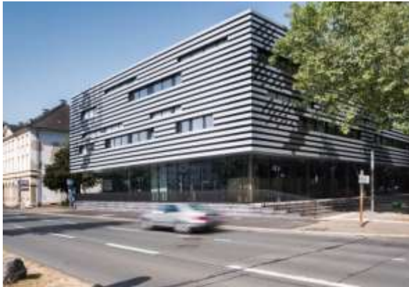
Abb. 21: Aufnahme des Gebäudes HC am Campus Haspel der Bergischen Universität Wuppertal (Quelle: Katharina Simon, Bergische Universität Wuppertal)
